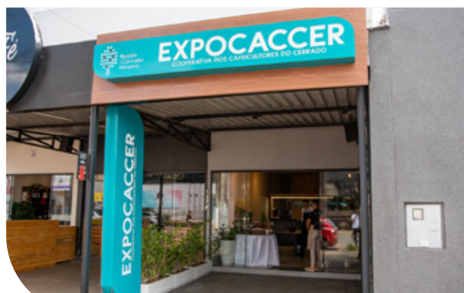
Fachada da Unidade de Atendimento em Patos de Minas – MG
